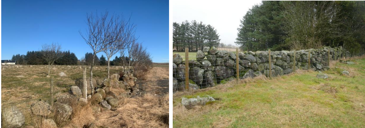
Figur 37: Steingjerder på landbruksareal innenfor planområdet. Steingjerde brukt som inngjerding mot beitedyr av dårlig tilstand og lav bevaringsverdi (t.v.) og steingjerde i høy grad av opprinnelighet og høy bevaringsverdi (t.h.). (foto: Hå kommune, 2025)
