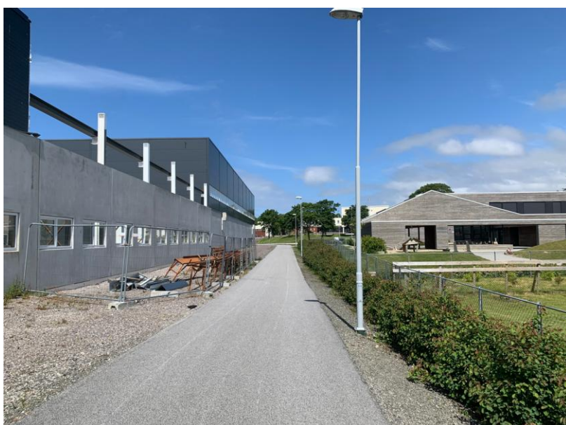
Figur 48: Etablert gang- og sykkelveg mellom industriområdet til venstre i bildet og Vigrestad barnehage til høyre. Bakerst i bildet ligger Vigrestad storskule (foto: Hå kommune, 2024)
