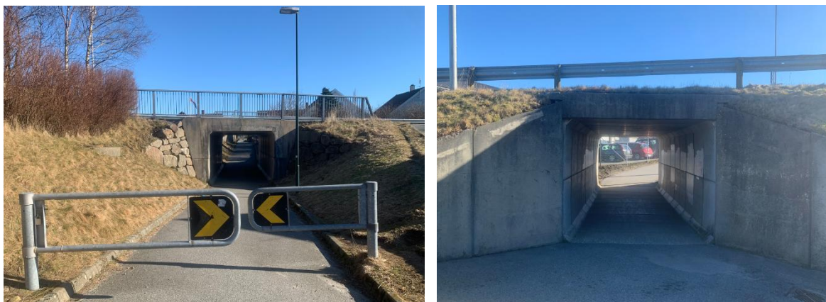
Figur 47: Underganger under Rundvegen. Undergang fra Hagane under Rundvegen (t.v) og undergang under Rundvegen mot Haugstadvegen (t.h.) (foto: Hå kommune, 2023)
