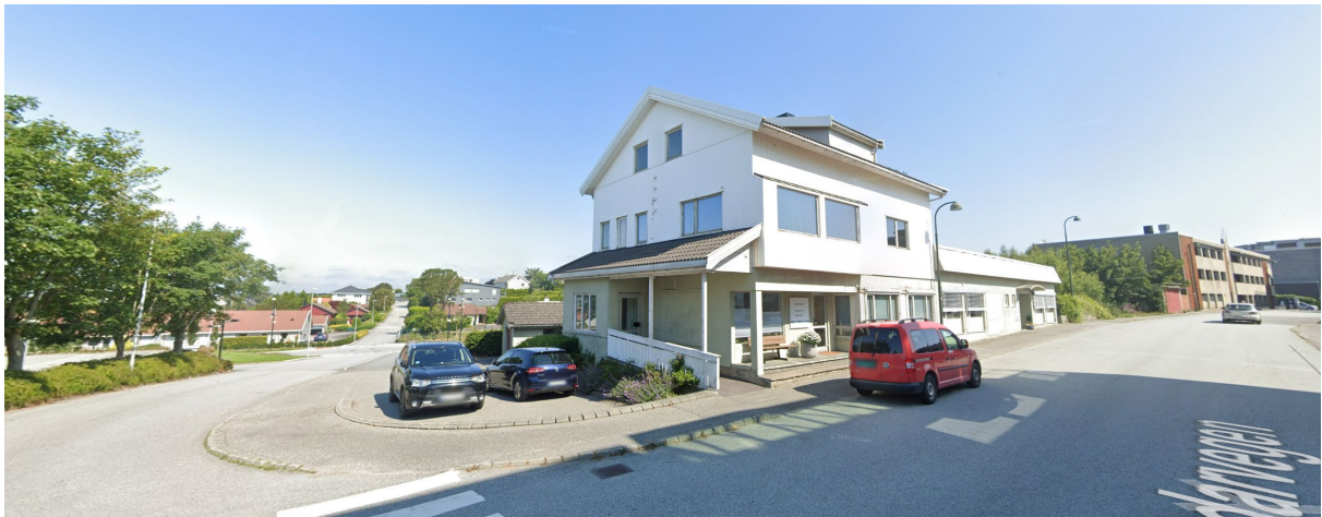
Figur 17: Jadarvegen 27 sett fra krysset mellom Jadarvegen og Dalvegen (foto: Google Maps)
