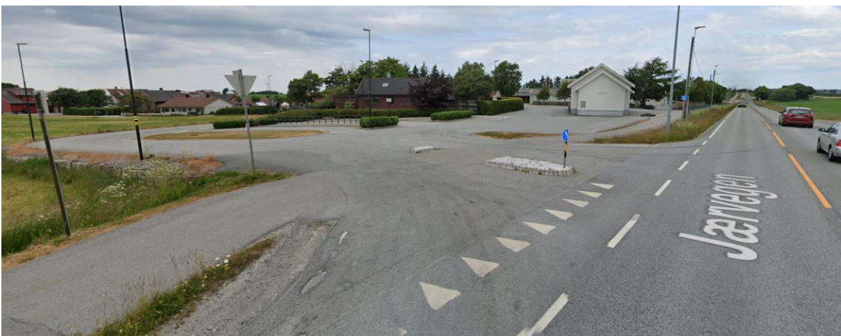
Figur 3. Utklipp fra Google Maps som viser avkjørsel til Høyland skule, på vestsiden av fylkesvegen. Langsgående gang- og sykkelvei krysser avkjørselen i plan. (Kilde: Google Maps).
