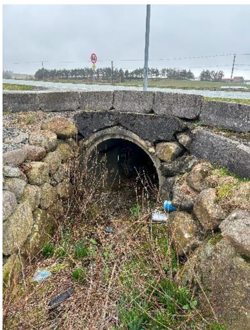
Kulvert under Haugstadvegen, dimensjon 1800 mm.
