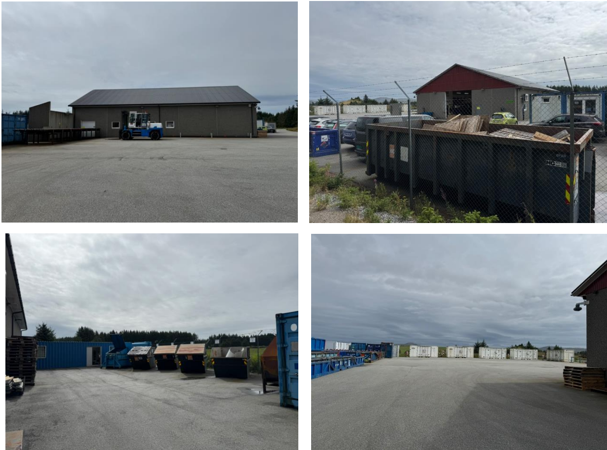
Figur 3: Eksisterende bebyggelse, containere og sikkerhetsgjerd.
