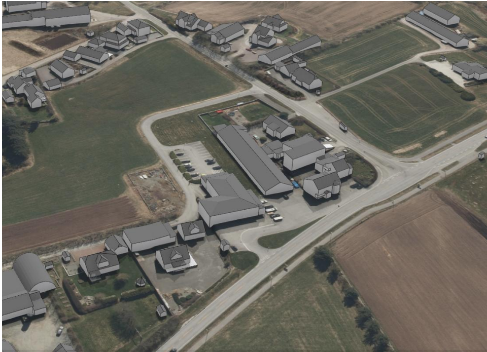
Figur 10: Bekkeheien legevakt og ambulansesentral sett fra nord
