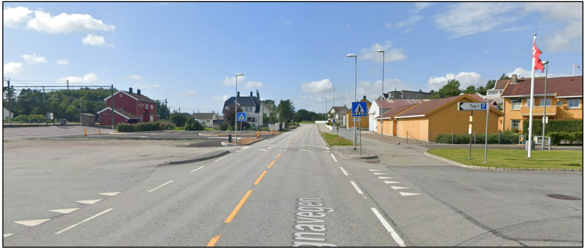
Figur 4-4: Gatebilde fra fv. 44 ved Oga stasjon i Oga, sett i retning nordvest (Google Maps)
