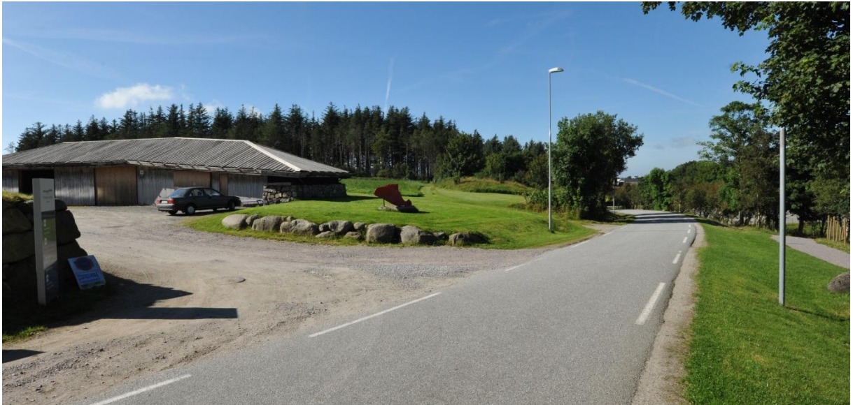
Figur 7 Adkomst til Jærmuseet, brukes av ansatte og ved varelevering og henting av renovasjon. Fylkesveg 156, Kviavegen høyre i bildet.
