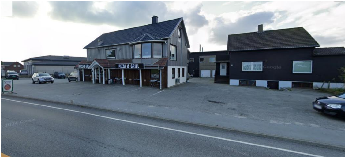
Figur 6: Bildet viser fortausforholdene på sørsiden av Jærvegen, hvor det ikke er godt nok skille mellom gangareal og område brukt av kjøretøy.
