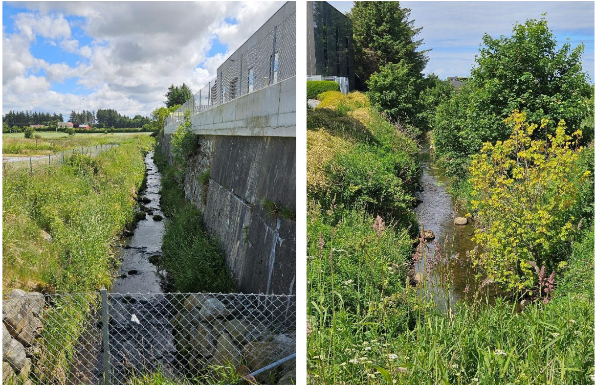
Figur 14: Til venstre vises den kanaliserte Bøbekken ved eksisterende næringsområde, med planområdet i bakgrunnen. Til høyre vises Bøbekken ved røråpningen vest for Torlandsvegen. Begge bildene er tatt av Hå kommune.
