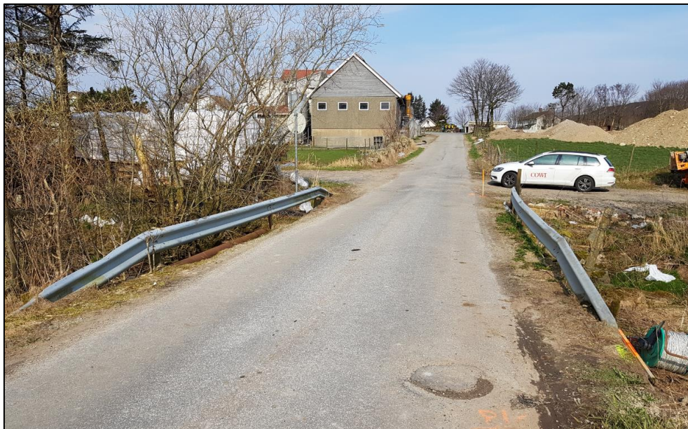
Figur 5-4: Bru over Rongjabekken, sett mot nord. (COWI AS, 2019).
