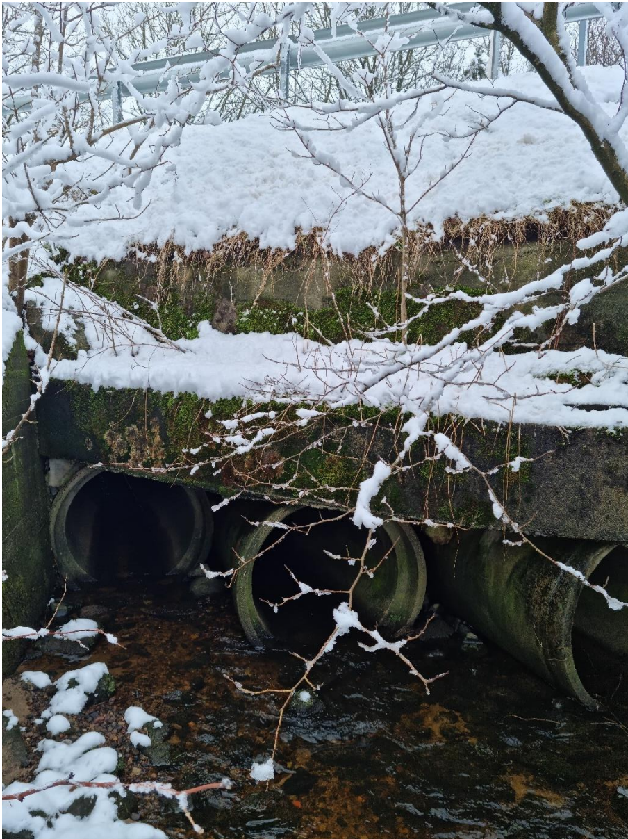
Figur 7: Bilde av innløp til stikkrenner under Opstadvegen.
