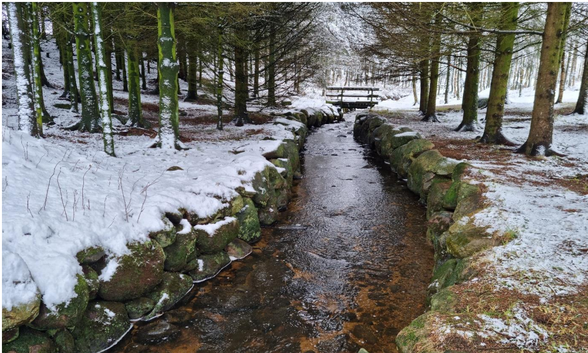
Figur 5: Bilde av kanalisert bekkeløp nedstrøms planområdet.
