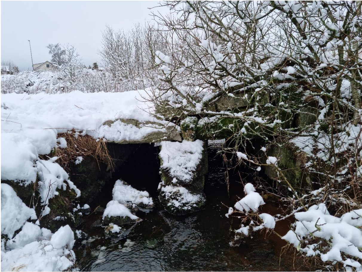
Figur 6: Bilde av bru langs privat veg, oppstrøms side.
