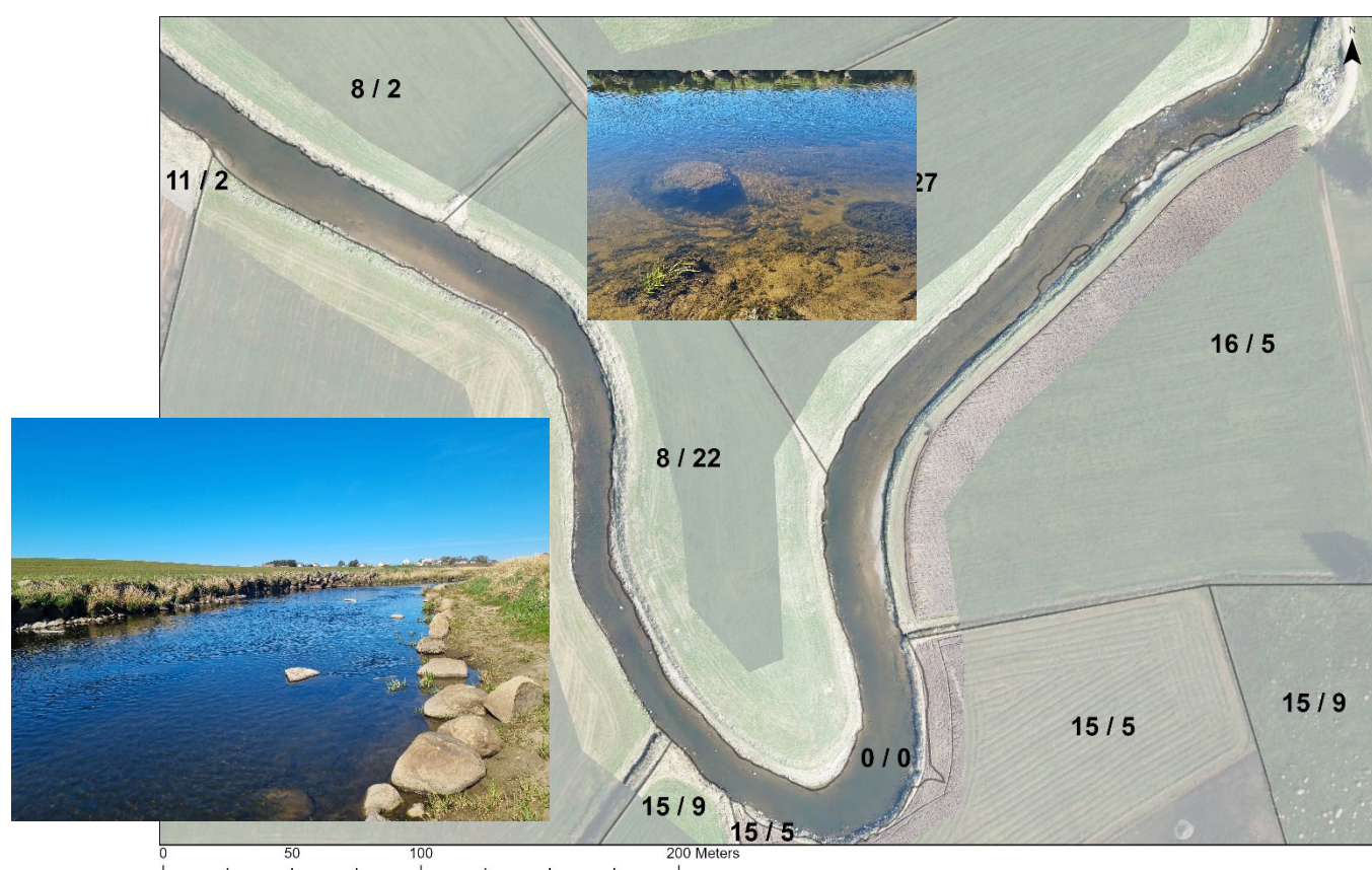
Figur 39: Delstrekning 16. Skråning ble trukket tilbake og blokkene gir bra variasjon i strømforhold. Steinrekken langs elvekanen var ikke planlagt men anses ikke som en ulempe heller. Det ble lagt torv på områdene på land. Fine gyteplasser oppstod rundt enkelte blokker.
