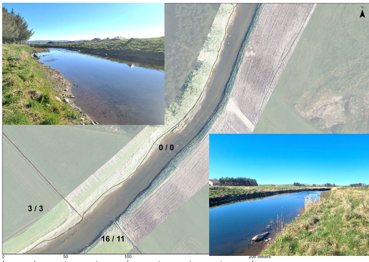
Figur 19: Delstrekning 7. Østsiden ble utformet bra med variert steinkant. På vestsiden ble det fjernet en del masser som har bygget seg opp over tid. Det ble lagt ut enkelte blokker, men mindre enn det som var anbefalt på arbeidstegninger. Tiltakene har forbedret habitatvariasjonen, men kunne vært enda bedre med flere blokker. Trærne som ble plantet har stort sett kommet opp og har en høyde på ca. 75 cm.
