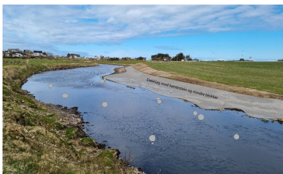
Figur 27: Delstrekning 11. Terreng ble senket mer enn anbefalt, delvis senket under vannspeil og etter at vi fikk de første bildene fra strekningen ble det sendt ut skisser for modifisering av tiltakene.
