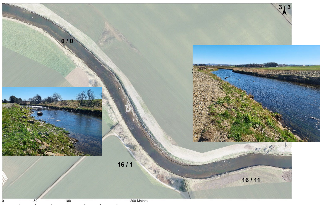
Figur 23: Delstrekning 9. Skråning av nordsiden ble justert, masser som har bygget seg opp langs land ble fjernet og det ble lagt ut mye stein og blokk som gir mye skjul i kantsonen og bra variasjon i elveløpet. Det ble lagt ut gytegrus og det har dannet seg gode gytemuligheter i denne strekningen også utenfor grusutleggene.
