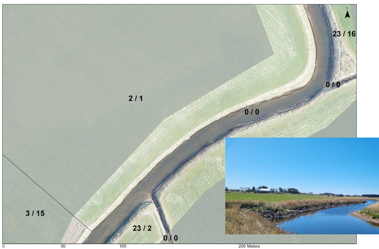
Figur 10: Delstrekning 4. Det ble lagt ut et fint lag med stein i skråningsfoten. Denne kunne med fordel blitt lagt litt lenger ut i elven for mer variasjon. Bra med skjul i elvekanten.
