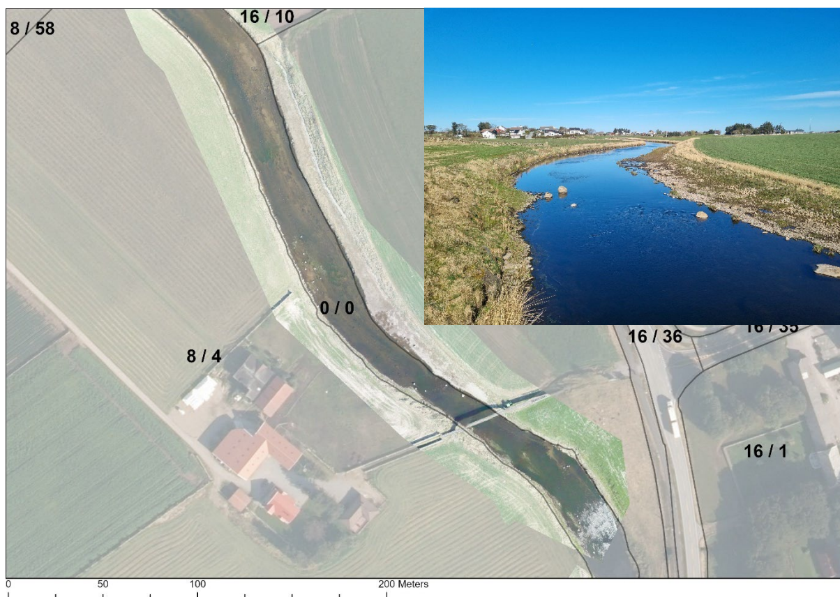
Figur 28: Delstrekning 11. Anbefalinger for modifisering ble gjennomført og strekningen har fått en elvekant med mye skjul. Terrenget ble senket for mye og det forventes at det bygger seg opp masser der over tid igjen som ikke bør fjernes.
