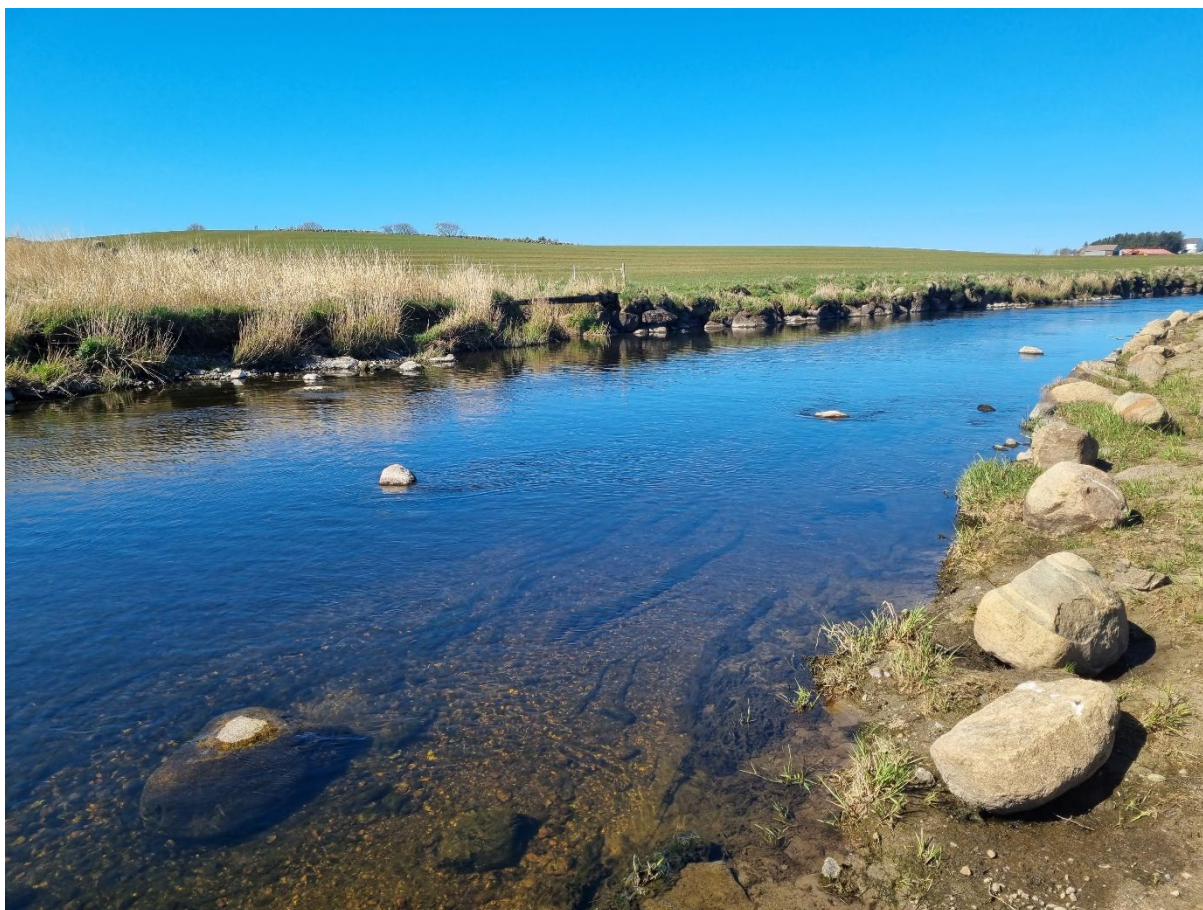
Figur 40: Eksempel på forbedret gytehabitat med blokkutlegg.
