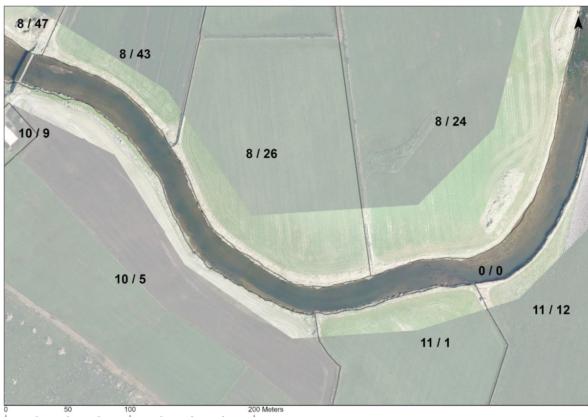
Figur 46: Delstrekning 19. Det ble fjernet en god del masser i innersvingen på nordsiden og det ble lagt ut blokker. Blokkutleggene var for små for å danne varierte strømforhold og det forventes at massene vil bygge seg opp igjen over tid.
