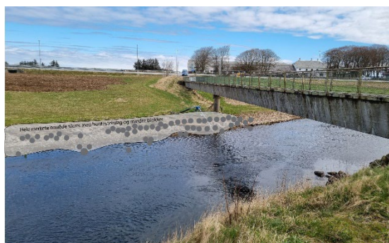
Figur 27: Delstrekning 11. Terreng ble senket mer enn anbefalt, delvis senket under vannspeil og etter at vi fikk de første bildene fra strekningen ble det sendt ut skisser for modifisering av tiltakene.
