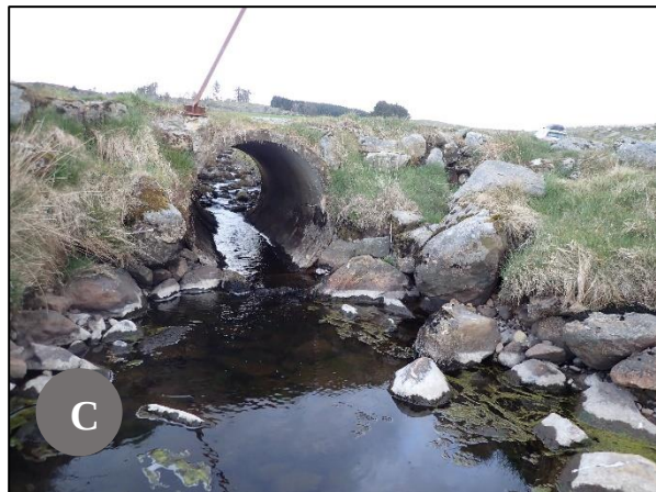
Figur 11. Det er en rekke kulverter og rør som er enkle å passere for fisk i Kvassheimsåna. A) Kulvert i segment 1. B) Kulvert i segment 5. C) Rør i segment 6.
