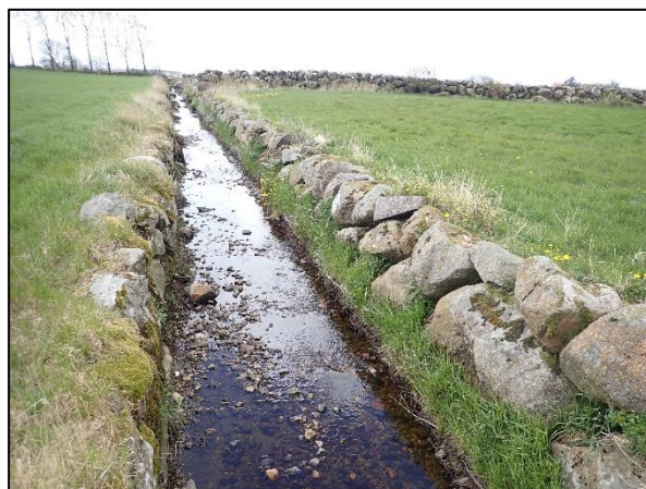
Figur 14. Øvre deler av bekken ved Herikstad er utrettet, forbygd og mangler kantvegetasjon.
