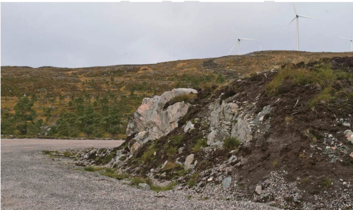
Figur 8 – Fjellskjæring kledd med løsmasser (kilde: Norconsult)
