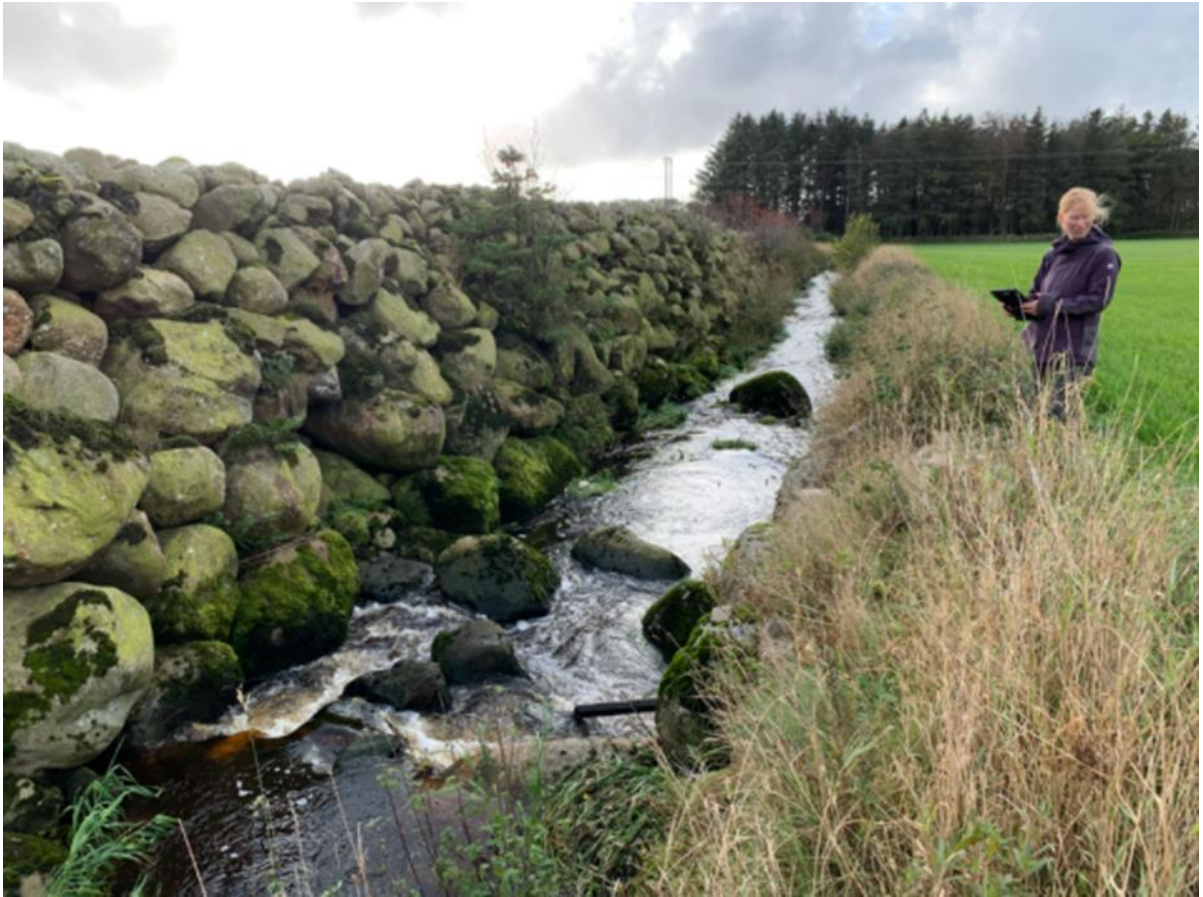
Figur 11. Reiestadbekken Oppstrøms Hålandsvegen. Steinsetting langs sørsiden har effektivt låst elveløpet. Kantvegetasjon mangler også på nordsiden, der dyrka mark går helt inn forbi 2 m sonen. Det er grus og stein i elva, men for liten variasjon til å skape skjul.
