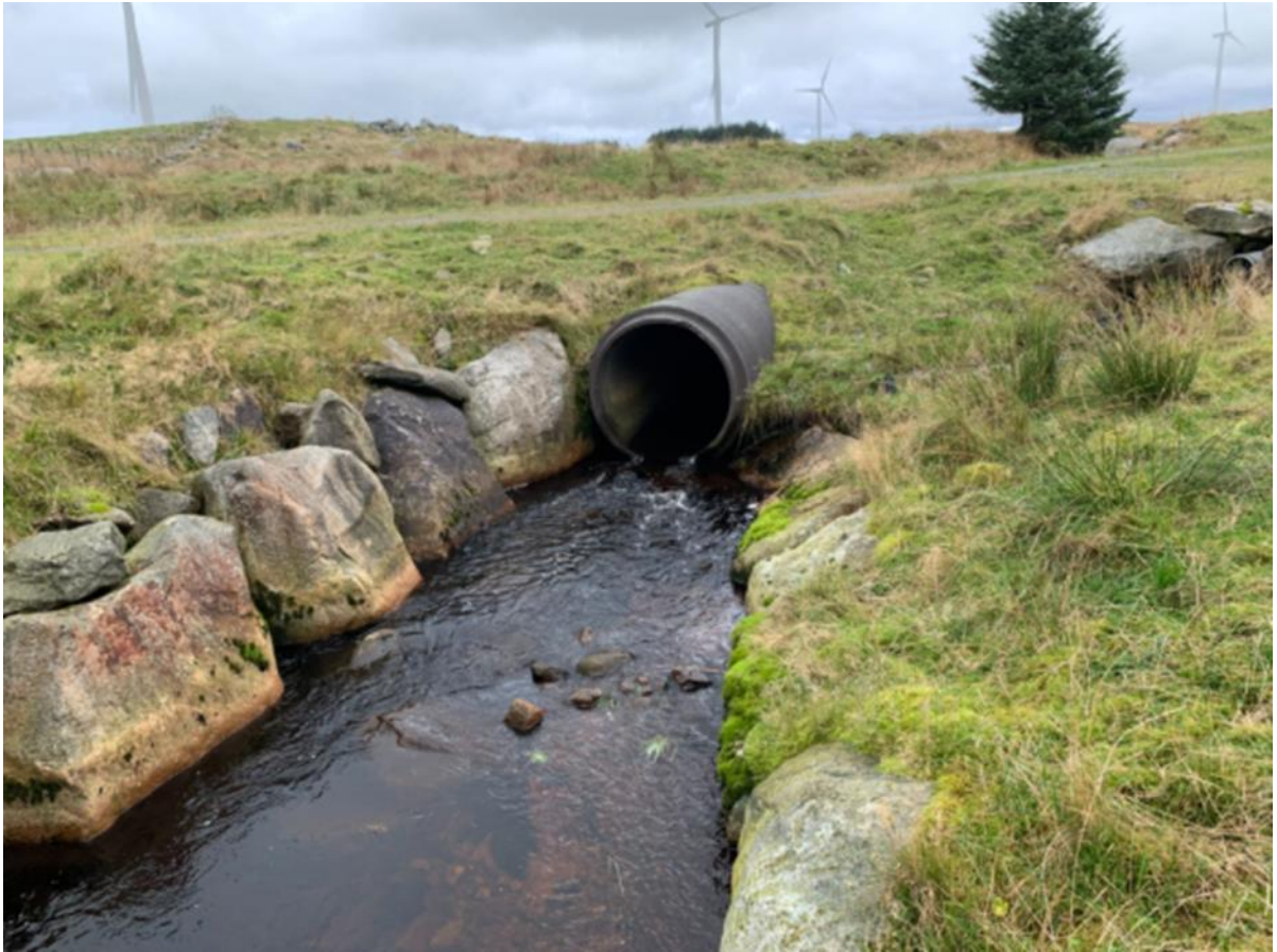
Figur 6. Tvihaugbekken ved vindmølleområdet. Fisk gyter på strekningen, men rør som ligger tørre ved lav vannstand utgjør vandringshinder for fisk. Her er det foreslått å legge å heve elvbunnen nedstrøms rørutløp.
