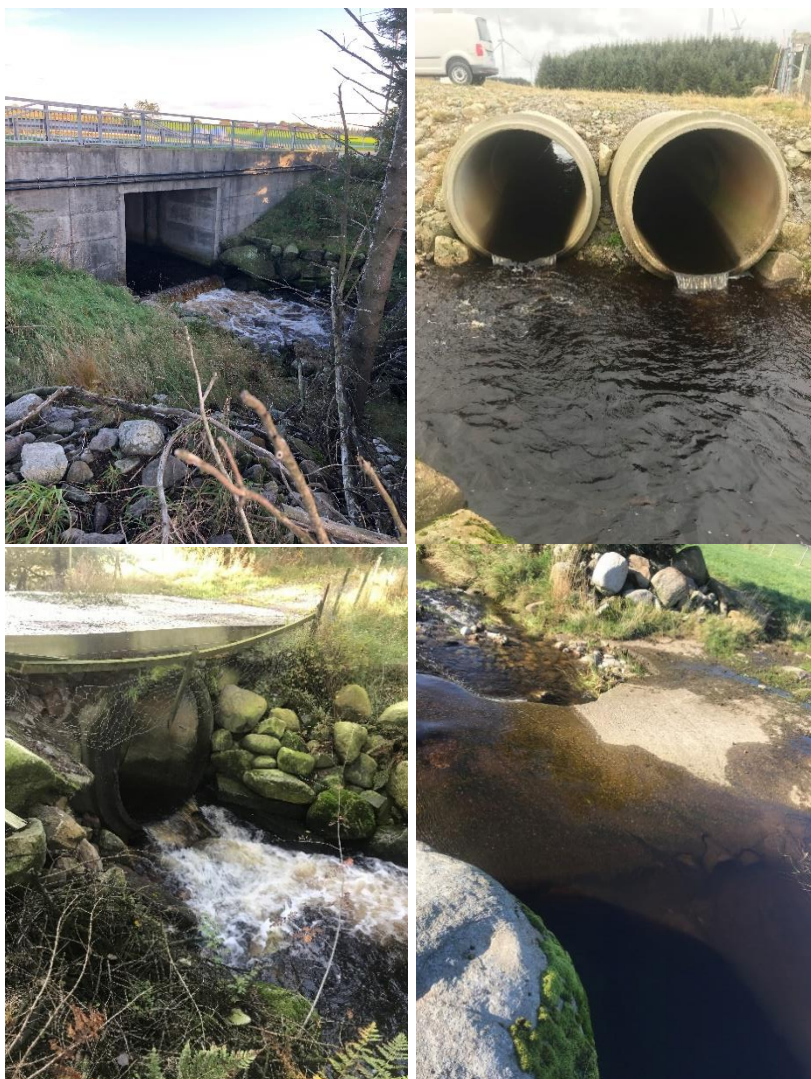
Figur 17. Eksempler på vandringshindre. Øverst til venstre: Tvihaugbekken ved Opstadvegen. Øverst til høyre: Tvihaugbekken ved vindparken. Nederst til venstre: Brattlandsåna nær Ualand. Nederst til høyre: mulig vandringshinder i Rongjabekken nedstrøms jernbanen. Foto: Rambøll
