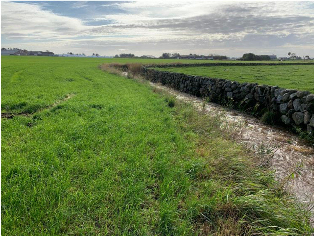
Figur 5 Rongjabekken. Utrettet og kanalisert elvestrekning med steinmur, uten kantsone eller kantvegetasjon.
