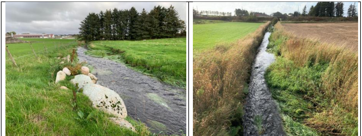
Figur 12. Reiestadbekken oppstrøms (v) og nedstrøms (h) Kyrkjevegen. Elva oppstrøms har et tilnærmet naturlig løp, mens elva nedstrøms er sterkt kanalisert og det er dyrket helt inn forbi 2 m sonen.
