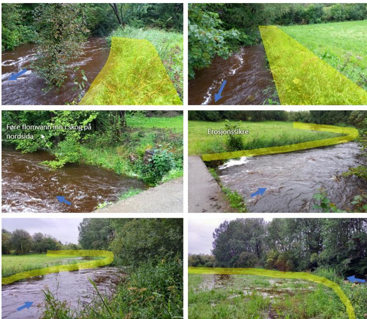
Figur 6. Tiltaksområde T-RI2 har erosjonsutsatte elvekanter som med fordel kan erosjonssikres med ru steinsetting (grovt avgrensede gule områder).
