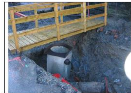
BUNNPLATE MONTERT PÅ KUM Ø650
