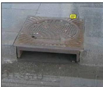
FERDIG MONTERT SLUK I GRANITTEENKE
