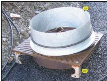
TOPPLATE PÅMONTERT SØTTEBEN (IKKE ORIGINALT)
