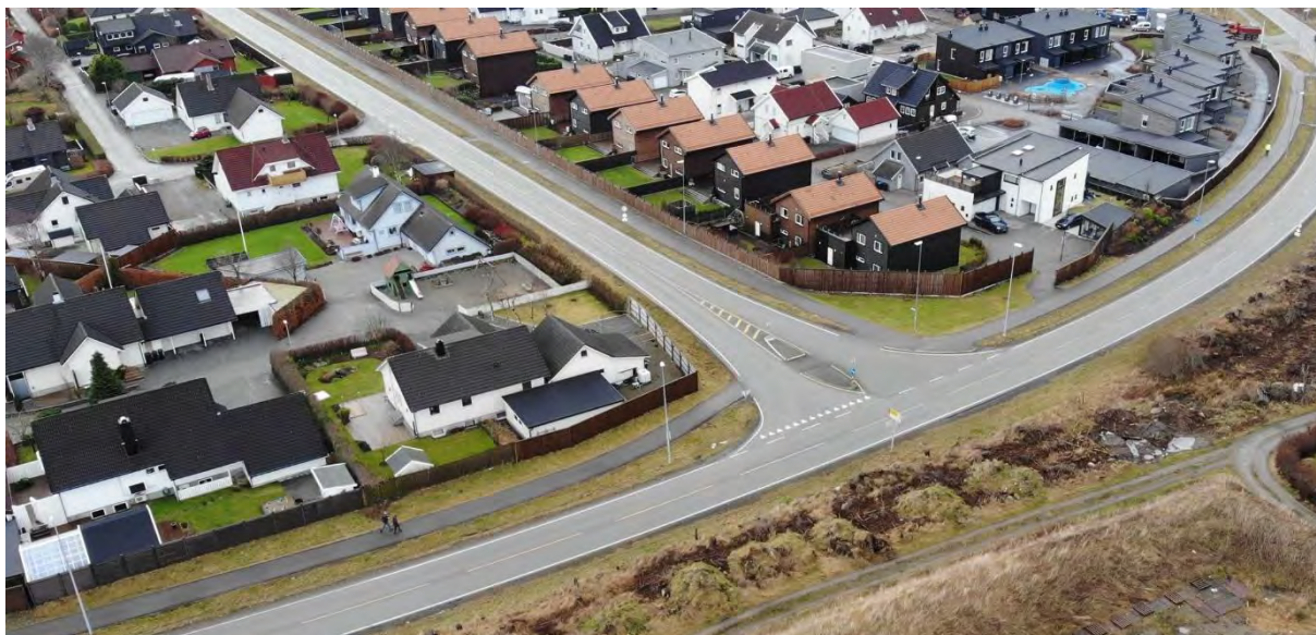
Figur 36: Støyskjerm langs Opstadvegen og Store Ring på høyre side i bildet (Dronebilde tatt av Mellgren, R. A. S., 2023)
