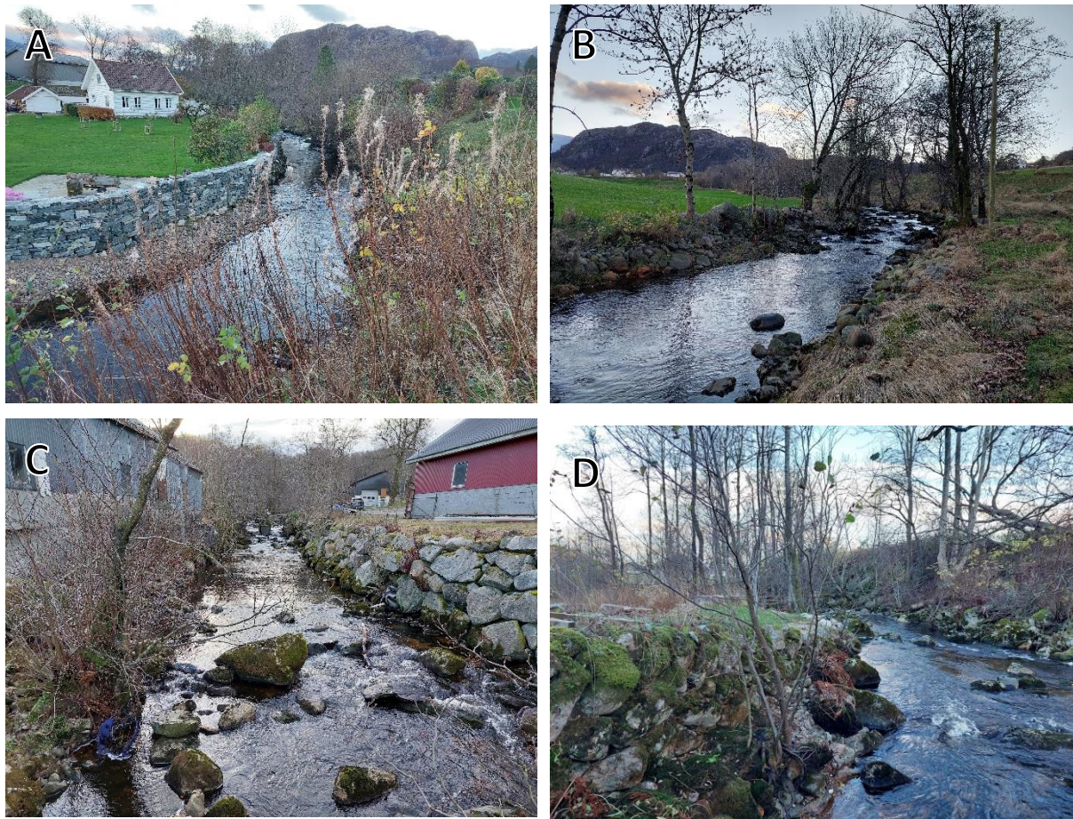
Figur 46. Morfologiske inngrep i Høleåna: A) Flomsikring og manglende kantvegetasjon i segment 1 og 2. B) Gamle tilbaketrunkne forbygninger og glissen og manglende kantvegetasjon i segment 2 og 3. C) Forbygninger og manglende kantvegetasjon i segment 10. D) Forbygning på vestsiden av elven i segment 4, som i liten grad påvirker habitatkvaliteten.
