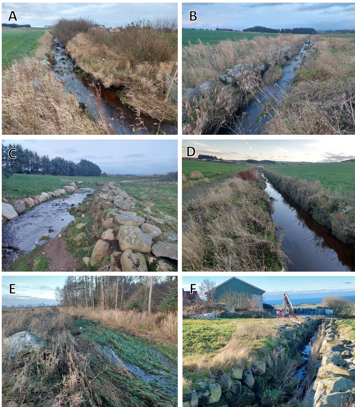
Figur 33. Morfologiske inngrep i Odlandsbekken: A) Manglende kantvegetasjon på den ene siden av bekken i segment 4. B) Kanalisert og forbygd elveløp og manglende kantvegetasjon i segment 15, der det har samlet seg relativt mye finstoff på bunnen. C) Delvis forbygd elvestrekning med manglende naturlig kantvegetasjon i segment 17. Forbygningen er delvis tilbaketrukket, og elven får i stor grad renne naturlig mellom forbygningene. D) kanalisert og utrettet strekning uten kantvegetasjon oppstrøms Kyrkjevegen (segment 25 og 26), hvor det har lagt seg opp mye finsedimenter på bunnen. E) Et langt parti med gjengrodd elvestrekning og manglende naturlig kantvegetasjon på den ene siden i segment 37. F) Kanalisert og utrettet strekning med manglende kantvegetasjon og delvis gjengroing i elveløpet, segment 40 og 41.
