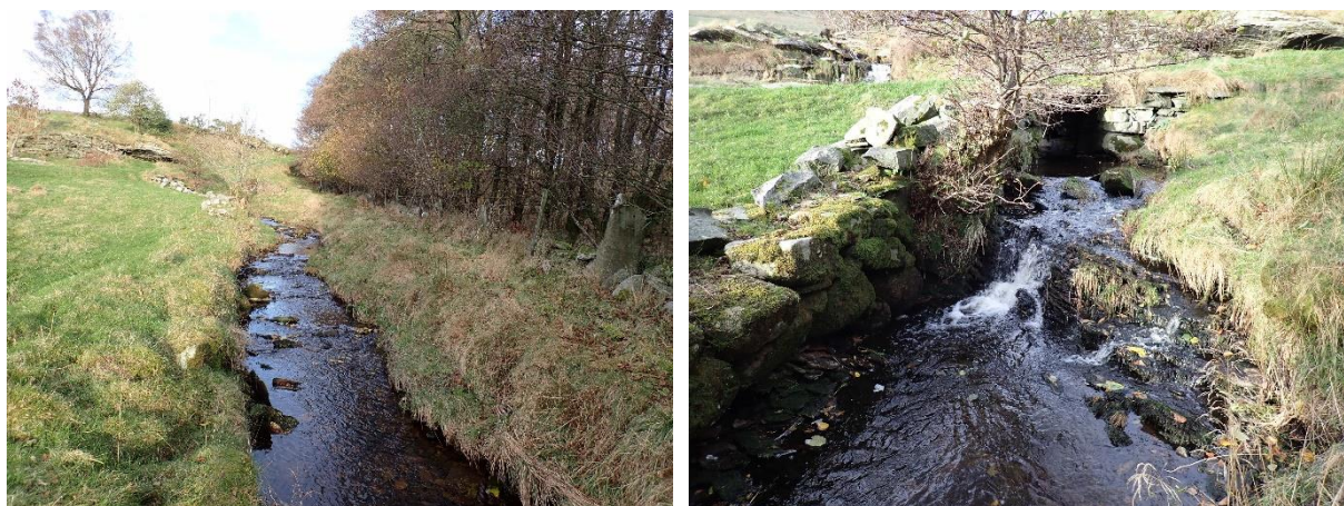
Figur 63. Morfologiske inngrep i bekk på Askje: A) Forbygninger og manglende kantvegetasjon i segment 10. B) Forbygninger, manglende naturlige kantvegetasjon, temporært vandringshinder og bekkelukking i segment 11.
