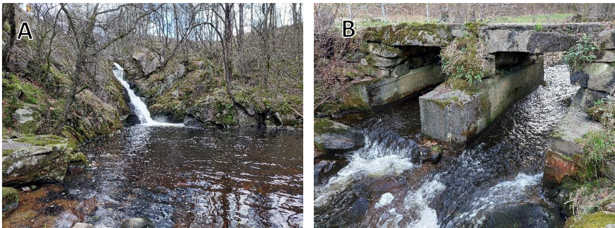
Figur 45. Vandringshindre og bekkelukkinger: A) Naturlig absolutt vandringshinder ca. 1,5 km fra sjøen. B) Den øverste kulverten har betong i bunnen, men er relativt enkel å passere for oppvandrende anadrom fisk.
