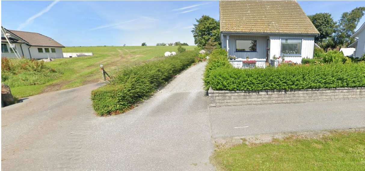
FIGUR 50 Viser Langgata 104, der avkjørselen saneres og det lages en kobling fra adkomsten mot Langgata 102.
