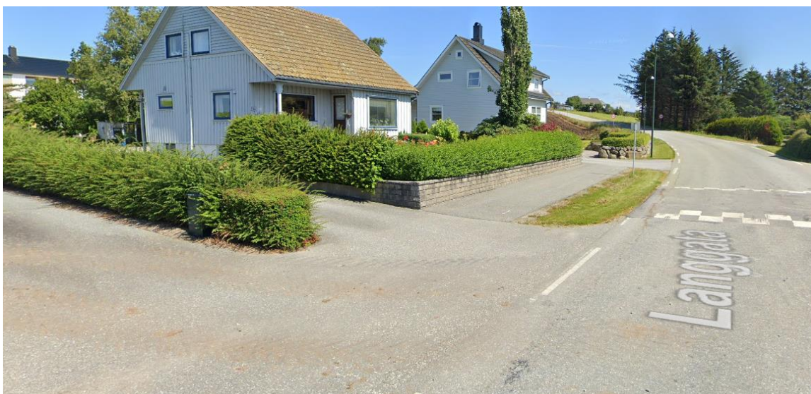
FIGUR 54 Ut ifra Google Street View (juli 2022) kan det se ut som at det er tidvis sikthinder av hekk innenfor frisiktsonen enkelte steder. Det er dog vanskelig å bedømme korrekt ut ifra kun Street View.
