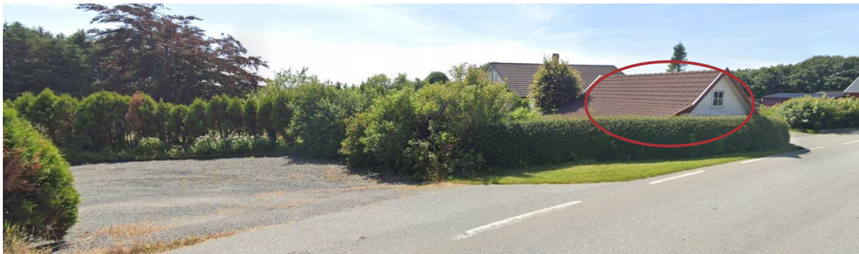
FIGUR 49 Viser eksisterende regulert avkjørsel til Langgata 111. Langgata 101 vises til høyre. Bygget med sirkel er det som er markert som rives i foreløpig plankart.
