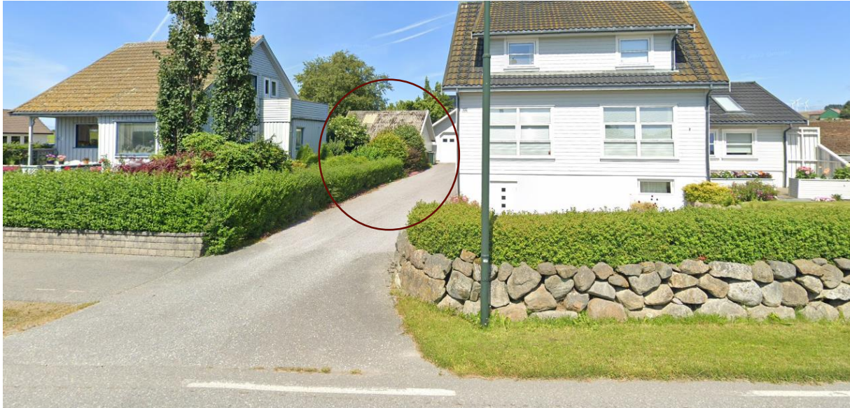
FIGUR 51 Langgata 104 og Langgata 106, man kan se bygg mellom husene som eventuelt må rives/flyttes for å få til adkomst i alternativ A.
