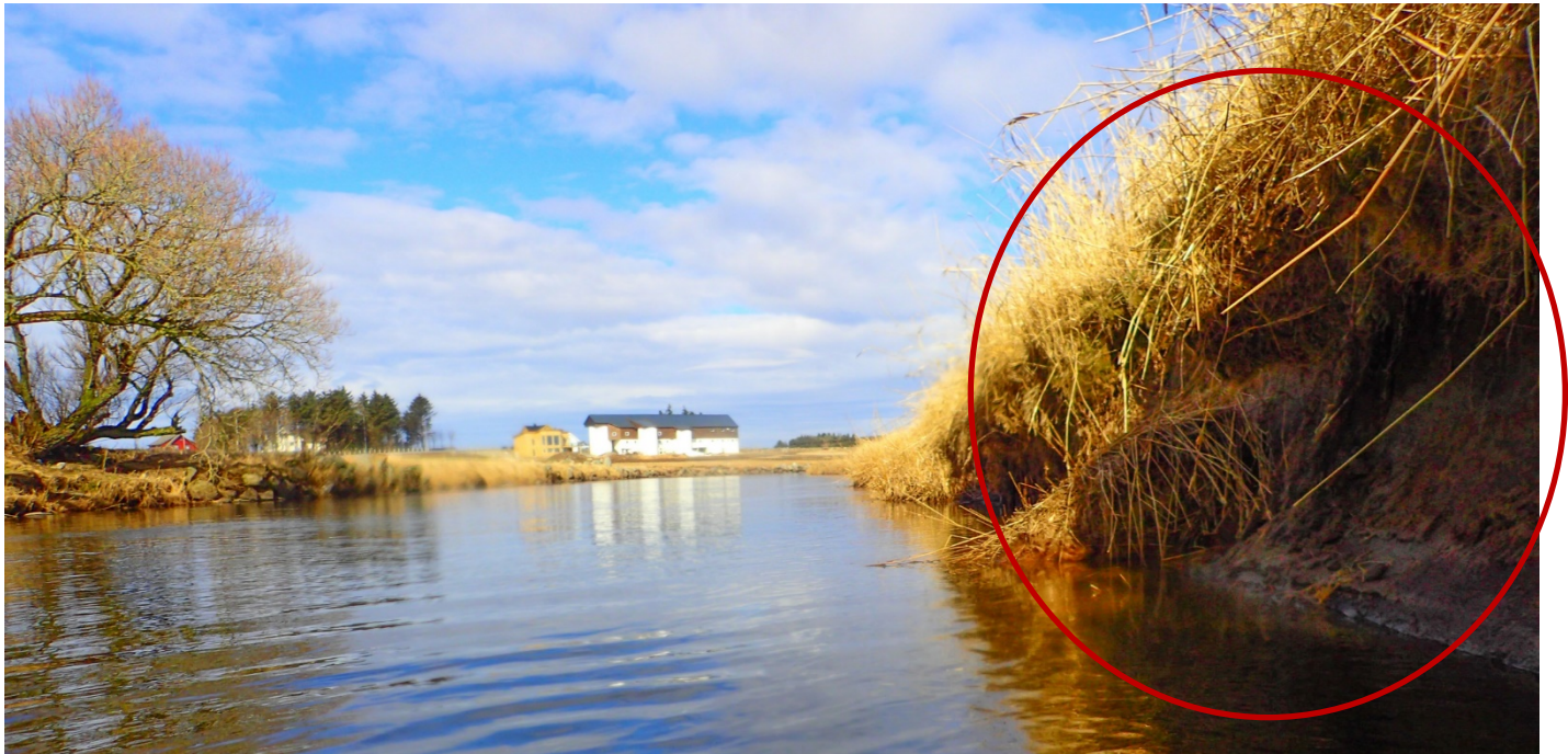
Figur 12: Utspylt elvekant oppstrøms Jærvegen bru.
