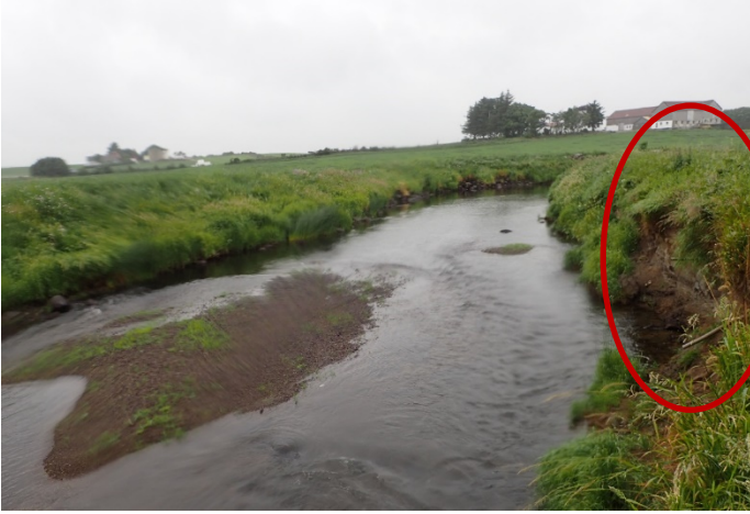
Figur 9: Erosjon i elvekanten anbefales å sikres ved å trekke skråningen tilbake og legge ut blanding av blokk/rullestein.
