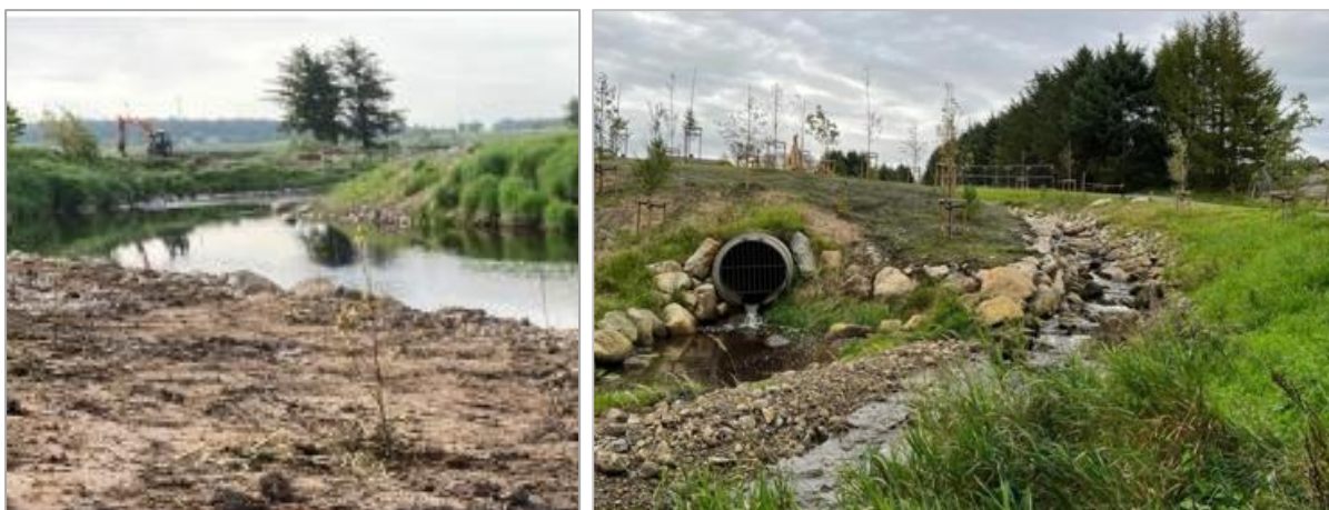
Figur 2-21. Utplanting av busker og trær er anbefalte tiltak i kantsonen. Her fra Håelva, hvor elvekantene har blitt erosjonssikret, og fra Dalabekken på Nærbø der bekkelukking har blitt gjenåpnet og tresatt. Foto: Karin Hansen Nærland og Maya Runde Stølen.
