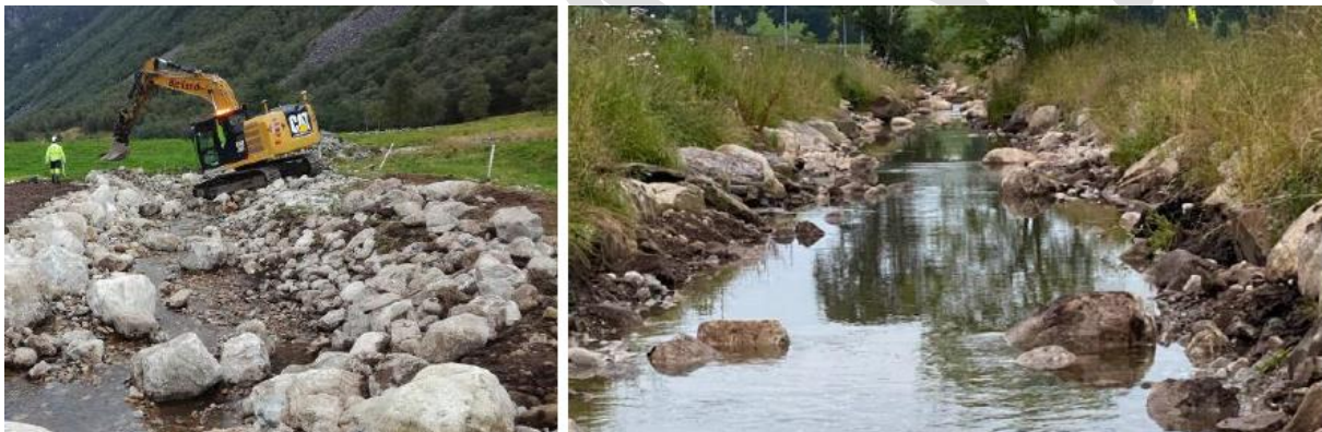
Figur 2-6. Miljøvennlig erosjonssikring av typen ru erosjonssikring i strykparti i Dirdal (t.v.) og i Kvernbekken i Klepp (t.h.). Bildet t.h. er tatt av Knut Ståle Eriksen, NJFF.
