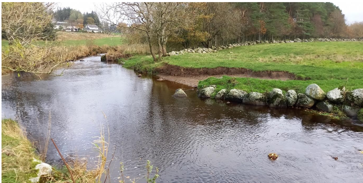
Figur 3-6. På Mauland er det aktuelt med ru eller tilbaketrukken erosjonssikring og utlegg av 4-5 blokk for å tilrettelegge for bedre gyteforhold.
