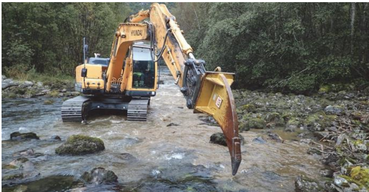
Figur 2-7. Eksempel på hvordan rensing av elvebunn utføres ved bruk av gravemaskin med rippeklo. Slik harving etterligner naturlige flommers selvrensende effekt med utspyling av finstoff fra bunnen. Figuren er hentet fra Miljødirektoratets veileder Tiltakshåndbok for bedre fysisk vannmiljø (Pulg et al., 2017).
