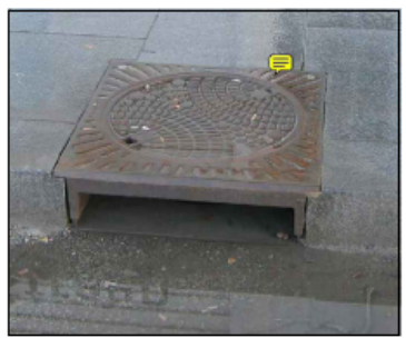
FERDIG MONTERT SLUK I GRANITTEKKE
