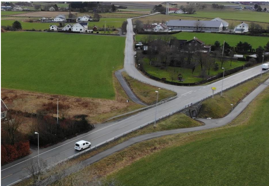
Figur 34: Kulvert under Opstadvegen til Indrebøvegen, tilgrenset planområdet som inngår som en del av reguleringsplanID 1063 (Dronebilde tatt av Mellgren, R. A. S., 2023)
