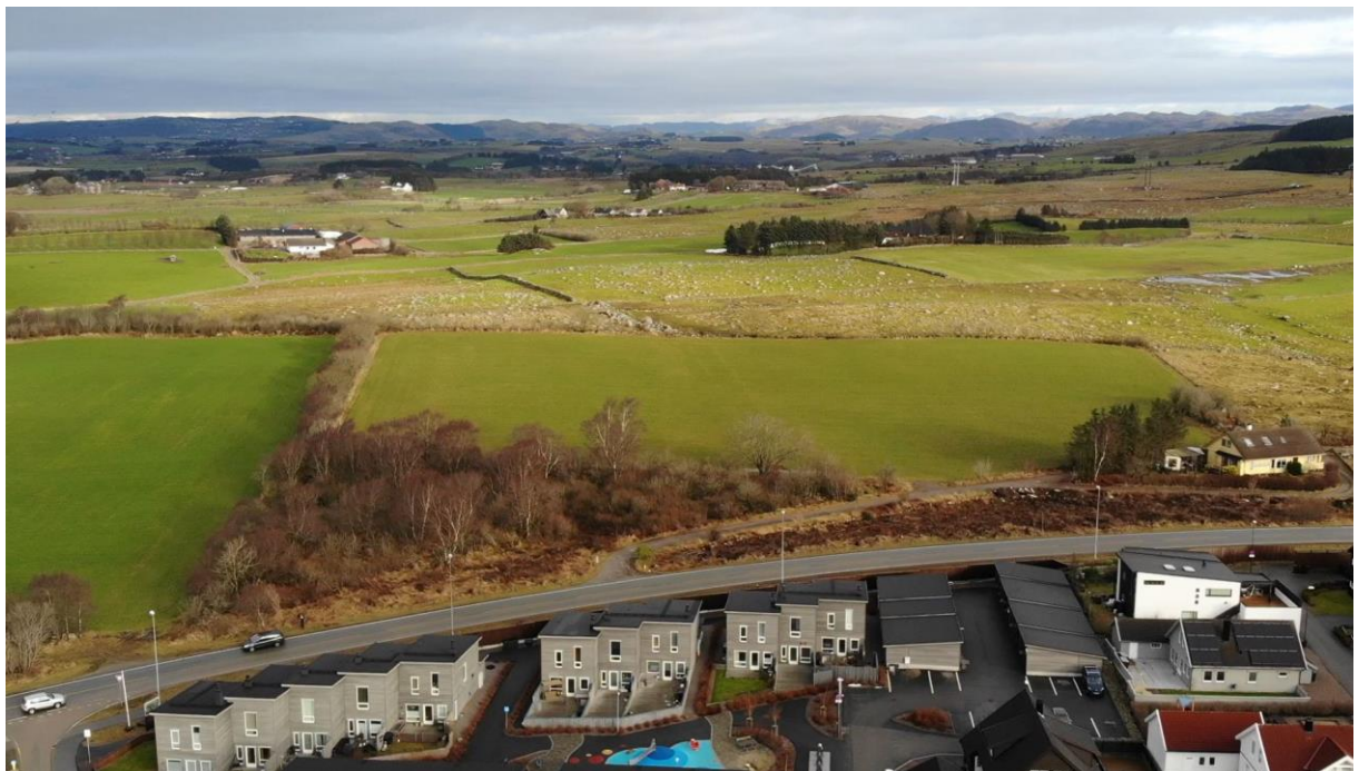
Figur 53: Eksisterende avkjørsel til gnr.26 bnr.61 i midtre del av kjørevegen som blir nødveg til brannstasjonen (Dronebilde tatt av Mellgren, R. A. S., 2023)
