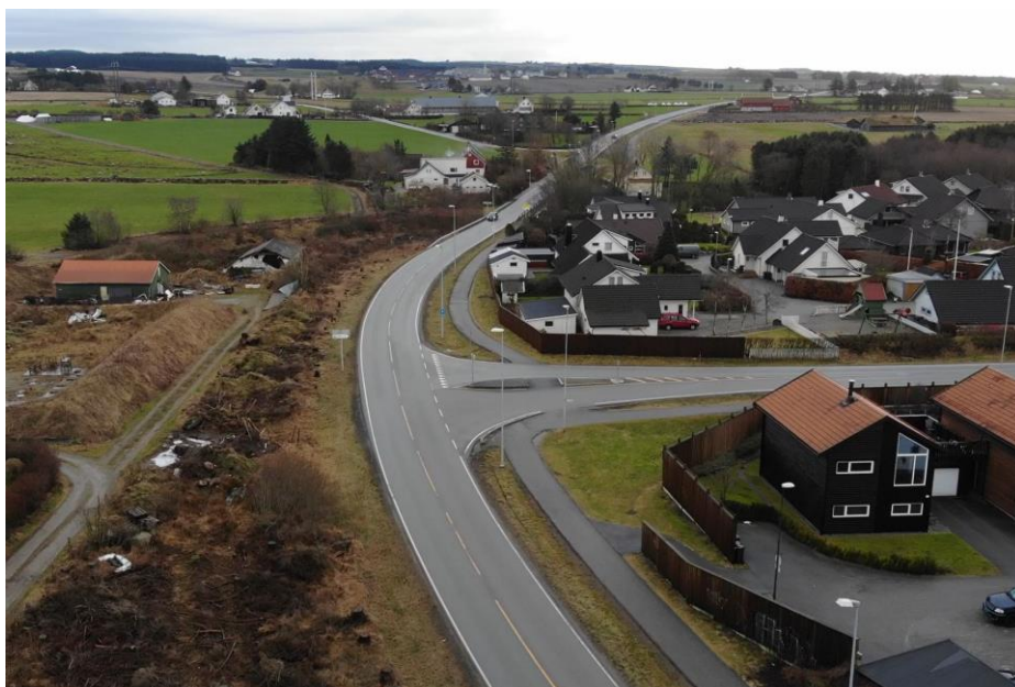
Figur 33: Eksisterende gang- og sykkelveger langs ene siden av Opstadvegen og Store Ring med tilrettelagt kryssing over Store Ring (Dronebilde tatt av Mellgren, R. A. S., 2023)
