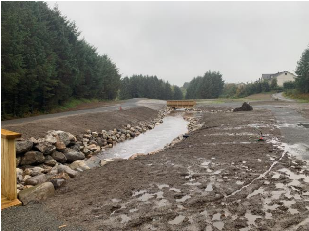
Figur 27: Området der det er gjort tiltak med å åpne opp bekkeløpet (Fra befaring 05.10.2022)
