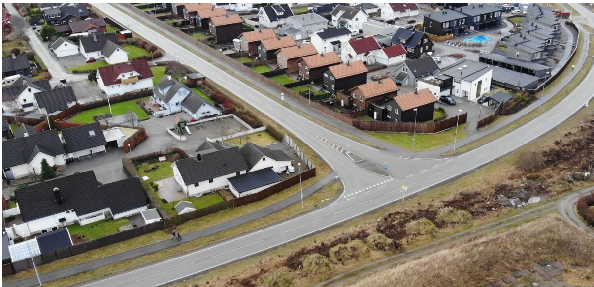
Figur 36: Støyskjermer langs Opstadvegen og Store Ring på høyre side i bildet (Dronebilde tatt av Mellgren, R. A. S., 2023)
