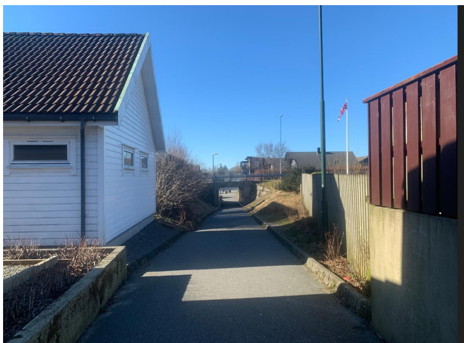
Figur 2: Gang- og sykkelveg gjennom undergangen, vist øst for Rundvegen.
