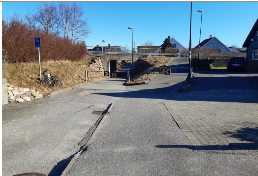
Figur 3: Gang- og sykkelvegen gjennom undergangen, vist vest for Rundvegen, samt tilhørende rampe. Nedre del av gs-vegene er montert med bom.
