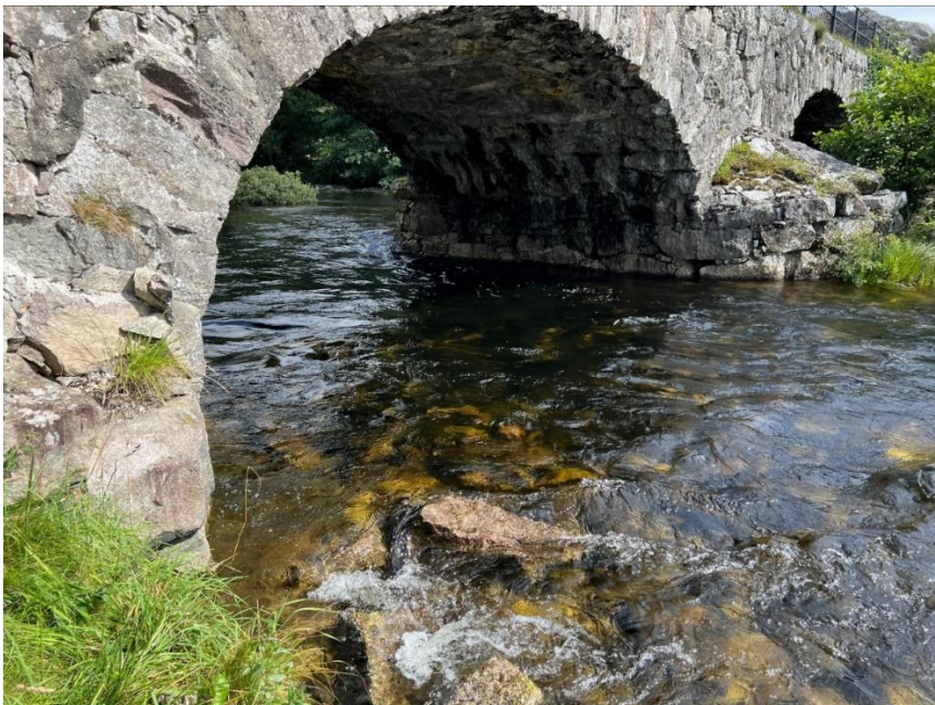
Figur 3 Hølland bru og illustrasjon av strømforholdene under befaringen.
