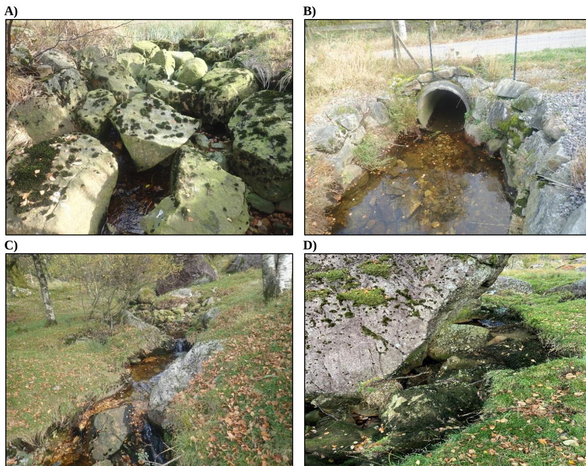
Figur 9.2. Vandringshindre og bekkelukkinger i Slåttedalselva: A) I segment 1 er det en kunstig terskel som utgjør et temporært vandringshinder for anadrom fisk. B) Røret under veien til segment 4 har uproblematisk passasje. C) Det nederste temporære vandringshinderet i segment 4 er krevende ved lav vannføring, spesielt for liten fisk. D) Naturlig absolutt vandringshinder som følge av en svær stein som blokkerer elveløpet. Passasjen ved siden av går tørr.
