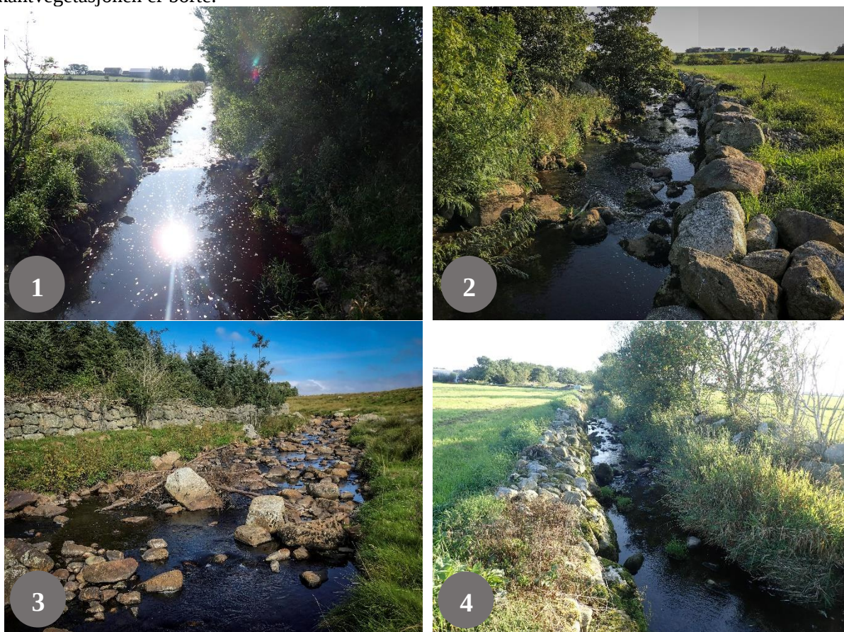
Figur 12. Bilder av inngrep i Nordre Varhaugselv tatt i perioden 3. – 5. september 2018. 1) Utrettet parti i sement N6, med steinmurer på sidene. Kantvegetasjonen er fjernet på den ene siden. 2) Parti av Tvihaugbekken i segment N3. Elven har steinmur langs ene bredden, hvor kantvegetasjonen også er fjernet. Den andre bredden har naturlig bank og kantvegetasjonen er intakt. 3) Tilbaketrukket steinmur i segment N7. Elveløpet er låst av muren, men har ellers naturlige banker. Kantvegetasjon mangler. 4) Utrettet og steinsatt parti med manglende kantvegetasjon i Rongjabekken, segment N13.
