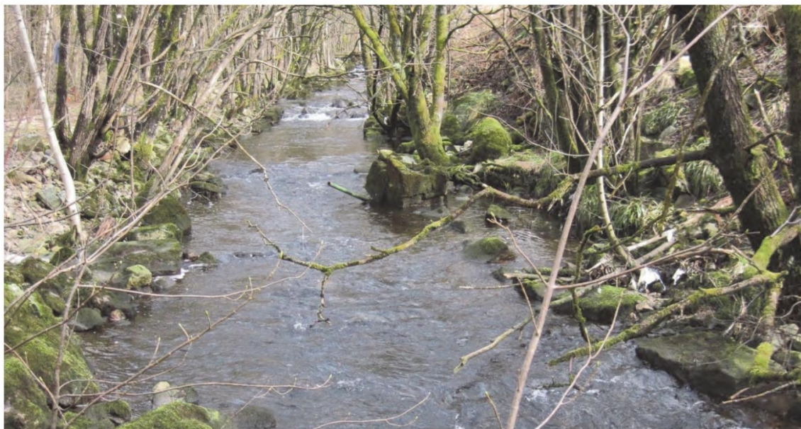
Figur 3. Eksempel på miljøvennlig erosjonssikring, med skrå kanter, uregelmessig steinstørrelse, og kombinasjon med kantvegetasjon. Gjengitt fra Miljødirektoratets tiltakshåndbok for bedre fysisk vannmiljø (Pulg, et al., 2018).
