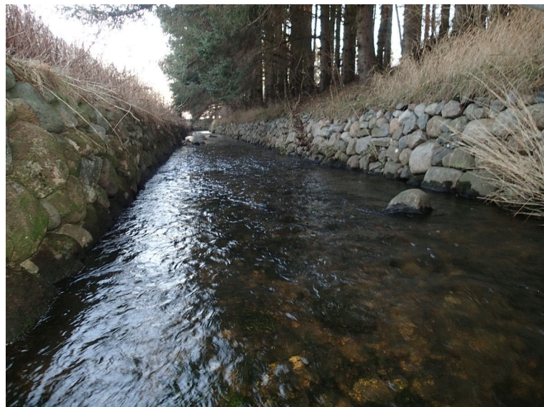
Oversiktsbilde fra Dalabekken.
