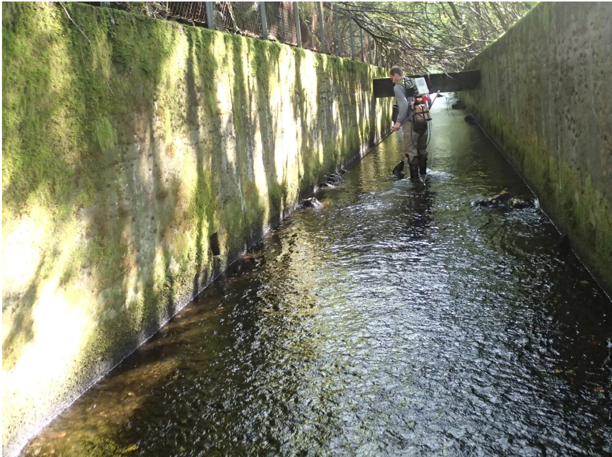
Fig. 1 Det er lite fisk i elvestrekninger som ble erosjonssikret med plastring eller betong fra alle kanter. Det mangler skjul, variasjon, gytegrus og tilgang til hulrom i elvebunnen. Strømhastigheter er for store ved flom og tilførsel av gytegrus og rullestein fra elvebredden er stoppet.
