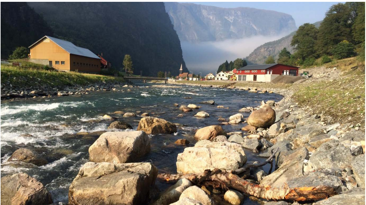
Fig. 12 Flåmselvi ovenfor Flåm kirke – bosetting krever erosjonssikring med stabil plastring langs yttersvingen. Foran plastringsfoten ble det etablert en variert elvebredd med naturtypiske steinblokker og rullestein som gir habitat for fisk og i tillegg sikrer plastringsfoten ytterligere mot erosjon.
