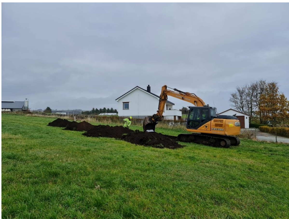
Figur 2: Arbeidsbilde, maskinell sjakting i Område 1, sett mot NØ.
