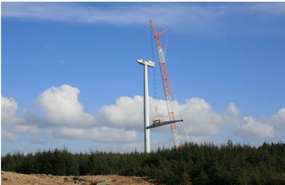
Figur 5. Installering av vindmøller på Høg-Jæren
