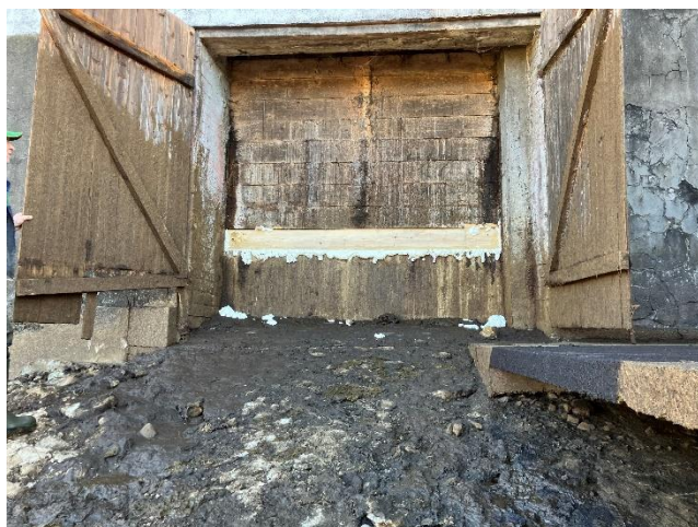
Her sprakk en bjelke i gjødselporten. En ny bjelke har blitt satt inn etter at mye gjødsel rant ut.
