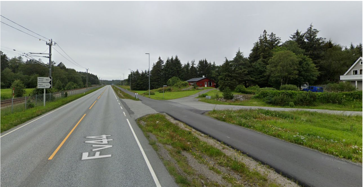
Figur 26 - Foto som viser avkjørsel til planområdet fra Nordsjøvegen. Avkjørselen er oversiktlig.
