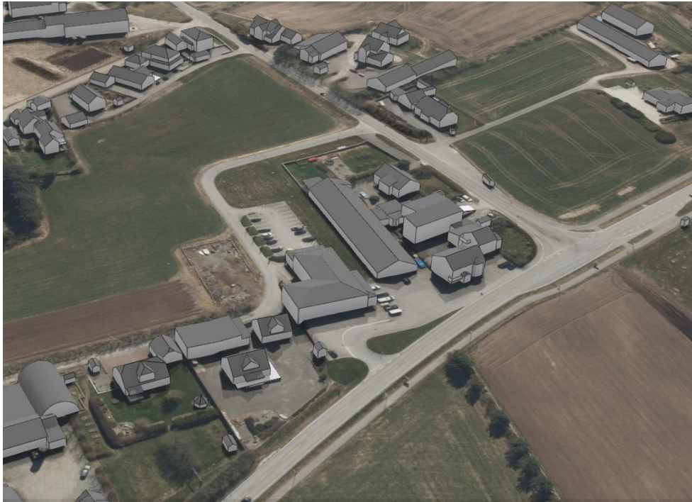
Figur 9: Bekkeheien legevakt og ambulansesentral sett fra nord
