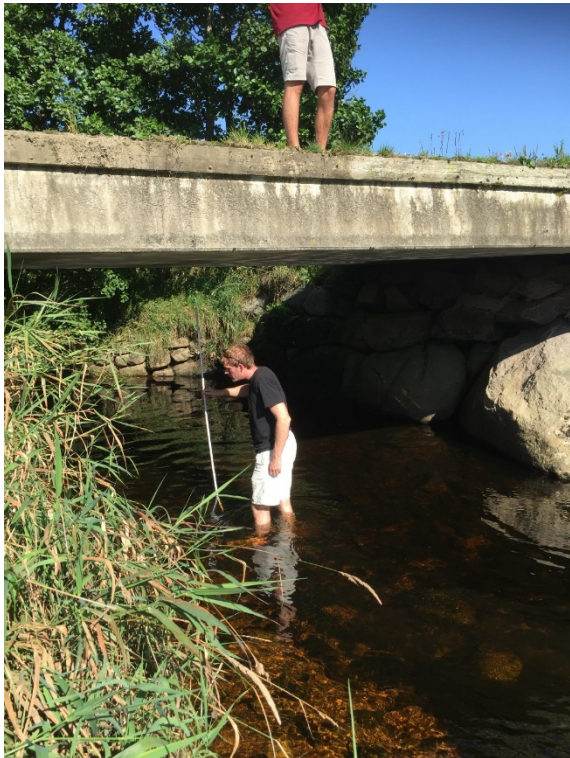
Figur 3 Kulvert nærmest tiltaket. Bredde 8 meter, høyde 2,5 meter
