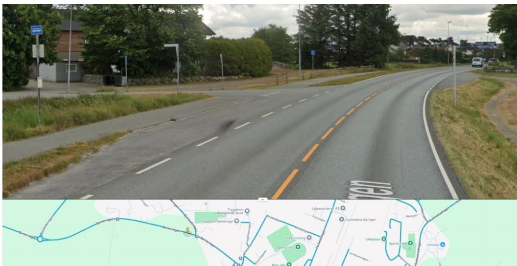
FIGUR 45 Eksisterende busslommer ved kryss Bernervegen x Bjorlandsvegen. Kilde: Google maps
