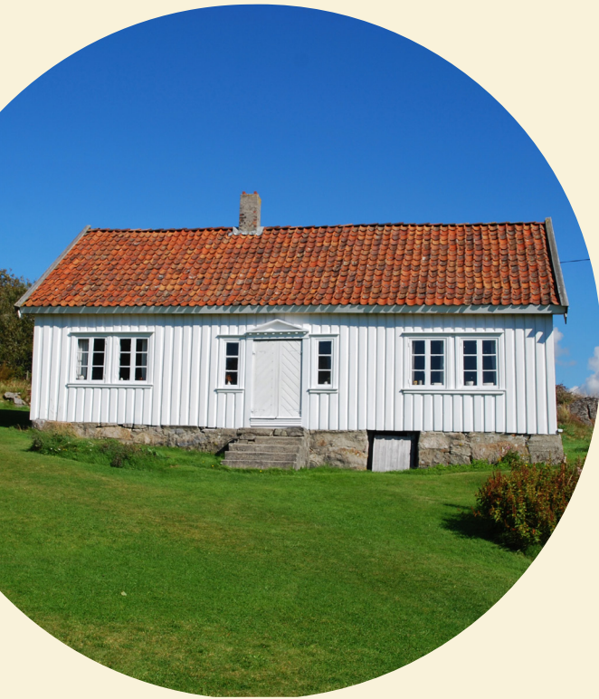
Holmane, byggeår 1700-talet
